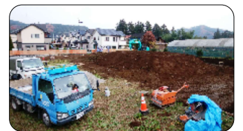
工事の状況（12月10日）
